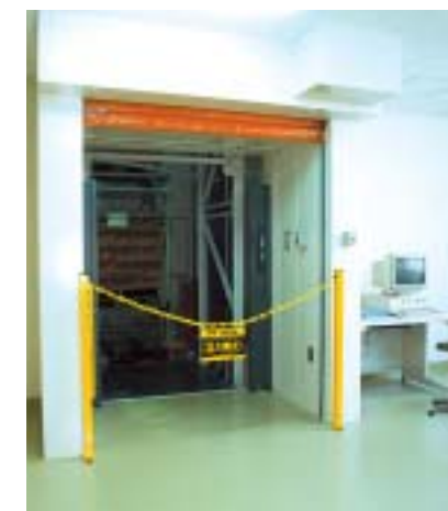
工場内自動倉庫出荷口
