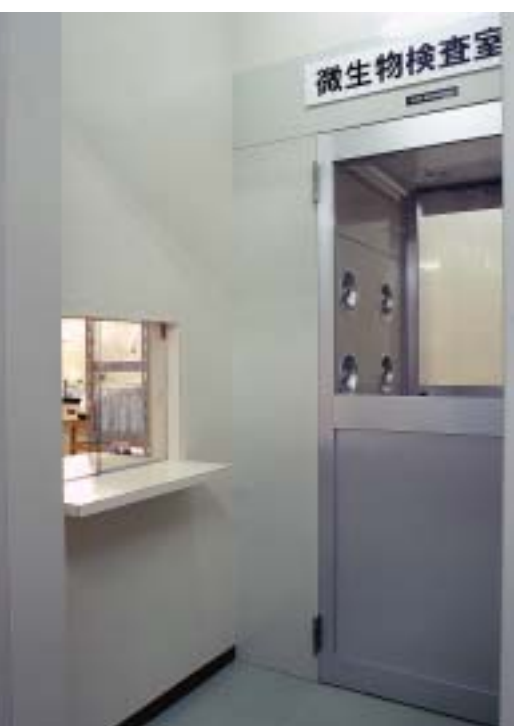
微生物検査室エアシャワー入口
