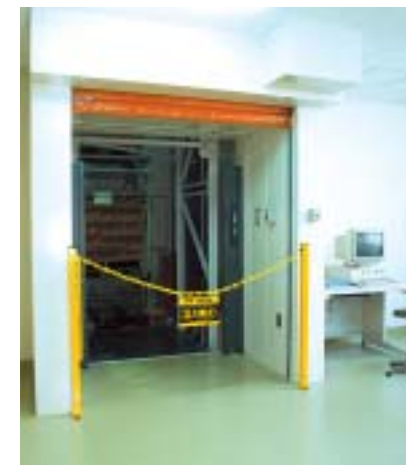
工場内自動倉庫出荷口
